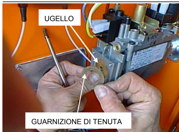
Figura 39 – Sostituzione ugello.
