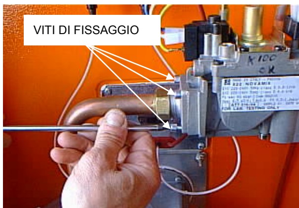
Figura 36 – Viti di fissaggio flangia gas.
